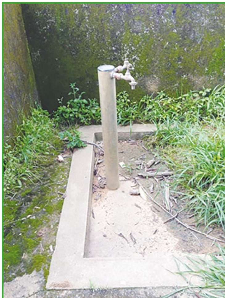
Photo 8 : Réseau d'adduction potable réhabilité par CAL et non fonctionnel
