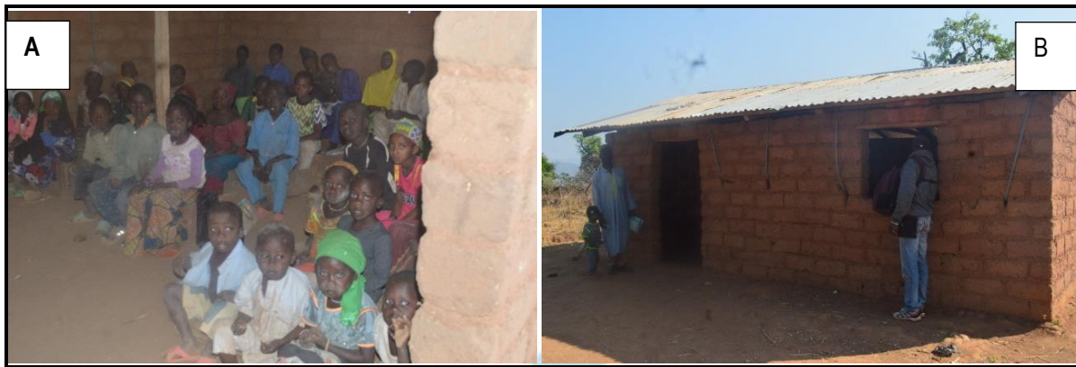
Photo 13 : Ecole publique de Mayo Léléwal cycle complet, vue de l'intérieur (A) et de l'extérieur (B)
