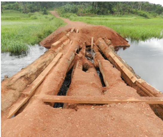
Photo 6: Pont forestier sur le Nyong
